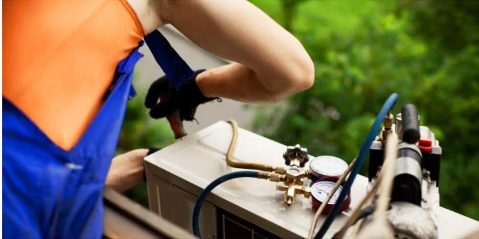
El cambio de compresor incluye lo siguiente: Desmonte unidad exterior y retirada al taller, limpieza interior de los caños con R141B para eliminar aceite viejo y partículas ajenas, limpieza general de unidad exterior con hidro-lavadora si es necesario, cambio de capacitor de arranque y mantenimiento del ventilador, Colocación del Nuevo Compresor e Instalación Unidad Exterior con Carga de Gas
